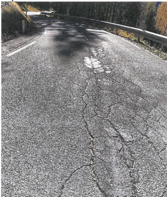
razpoke v cesti v km 2.800
